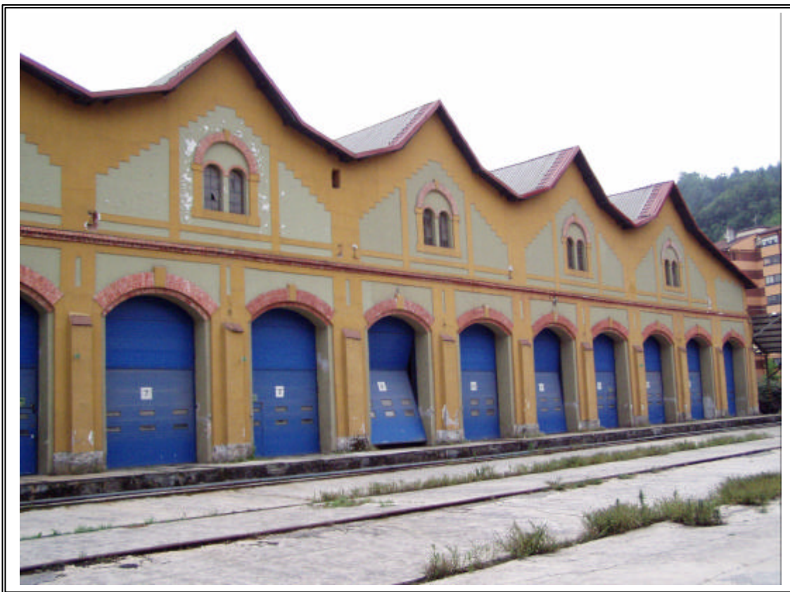
Fachada principal del Edificio F
