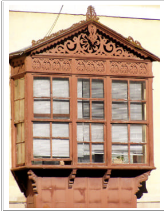
Detalle de mirador, en la fachada principal del edificio de vivienda.
