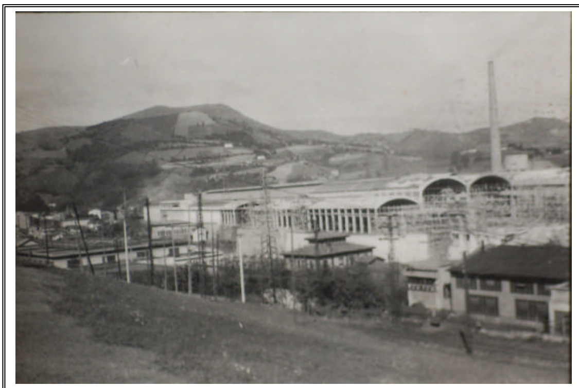
Las primeras bóvedas de hormigón documentadas en Gipuzkoa son éstas de la acería de Esteban Orbegoitz, proyectadas por Luís Astiazaran en la década de 1940 Vista de la factoría Esteban Orbegoitz (Zumarraga) en los años 50 Colección particular
