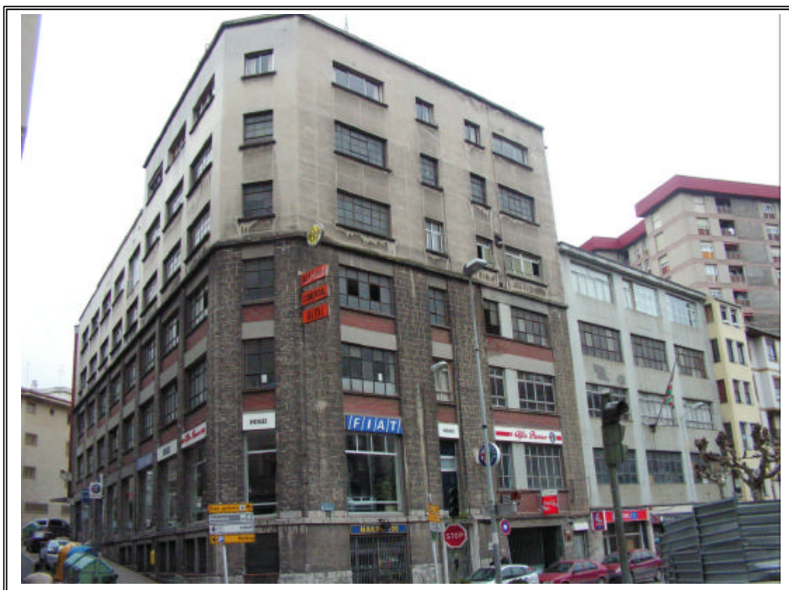
Vista actual del edificio
