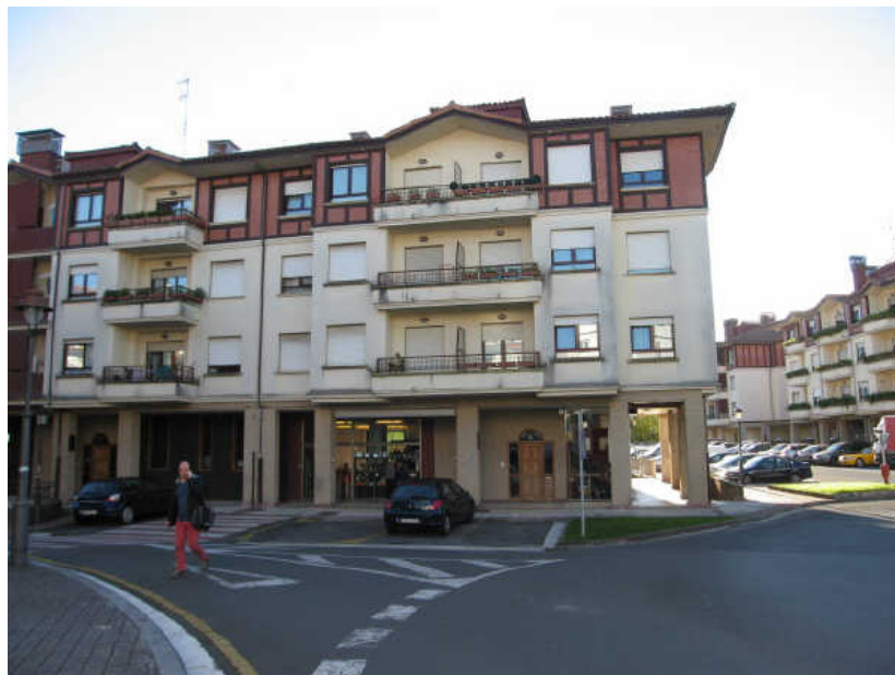
errekatziki,2 - fachada noroeste
