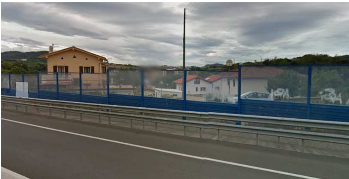
Pantalla acústica para proteger edificaciones en Oiartzun
