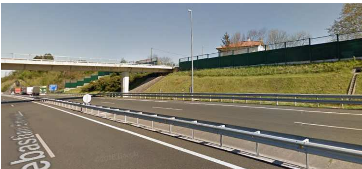
Imagen de unas de las viviendas aisladas más cercanas a la vía en la zona de Hernani, donde existe una barrera acústica
