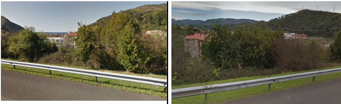
Bloques de edificaciones de diferentes alturas ubicados a ambos lados de la UME a su paso por el núcleo residencial de Orio
