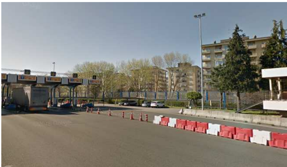
Zona del peaje de Zarautz, con bloques de viviendas de más de 7 alturas con protección acústica
