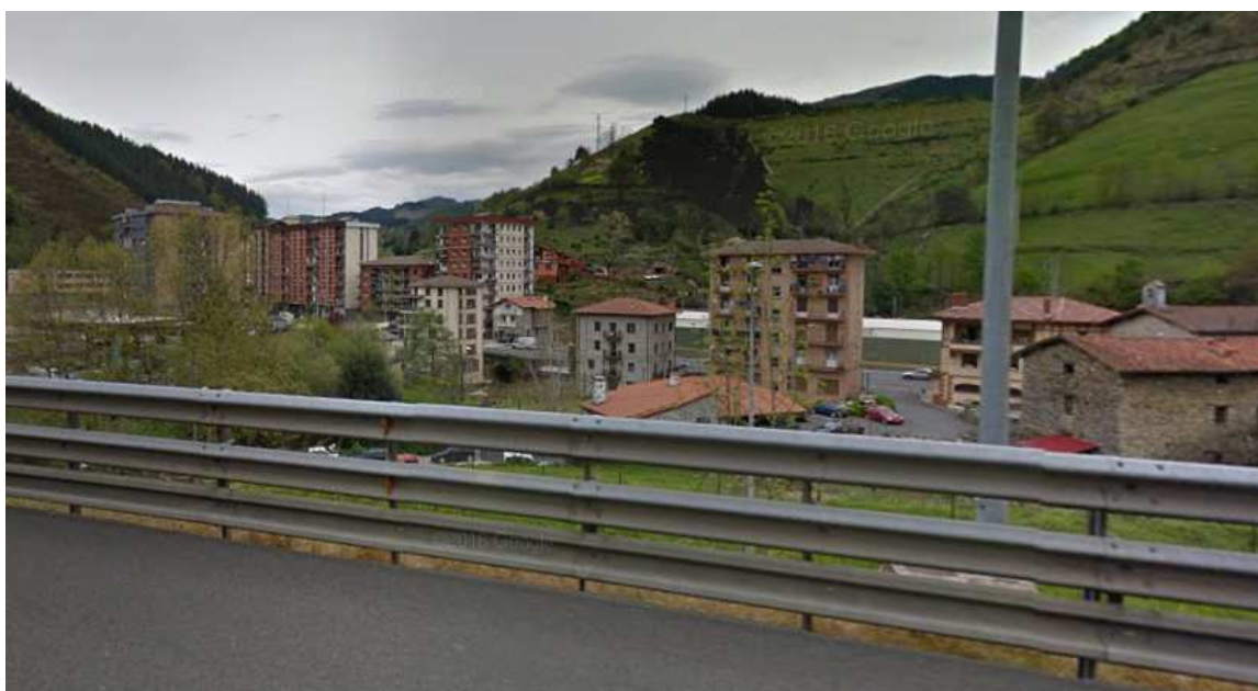
Paso de la AP-8 por Sallabente Auzoa, en donde se ubica, además, un centro docente
