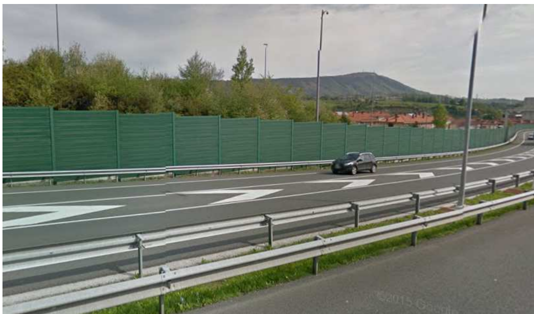
Pantalla acústica en la AP-8 en el ámbito de confluencia con la GI-20
