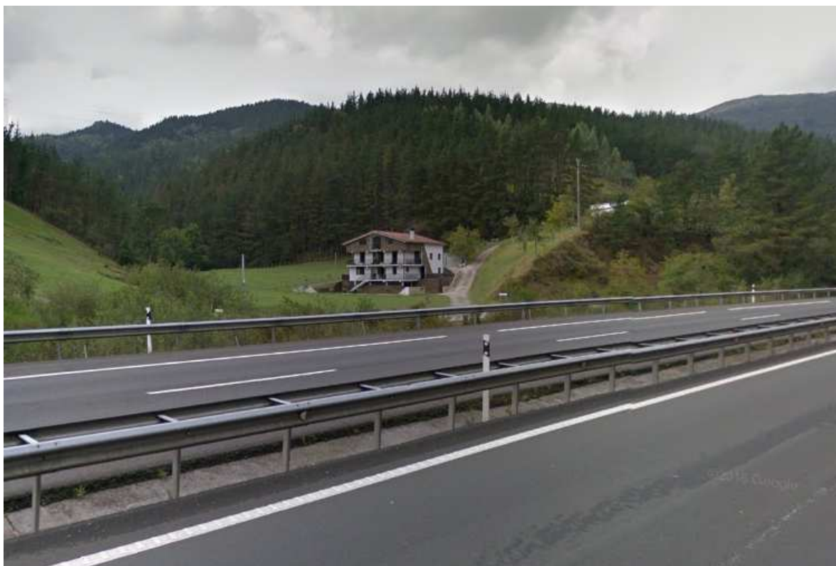
Viviendas unifamiliares aisladas en la traza de la AP-8
