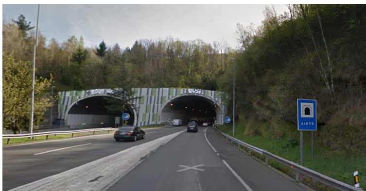
Túnel de Aiete (Barrio de Aiete)
