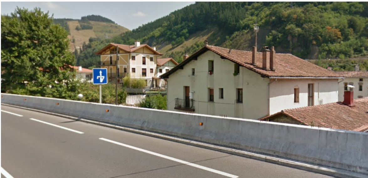
Viviendas de tipo unifamiliar a su paso por Bergara
