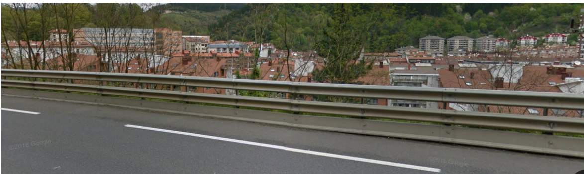
Paso de la carretera por el entorno urbano de Arrasate/Mondragon
