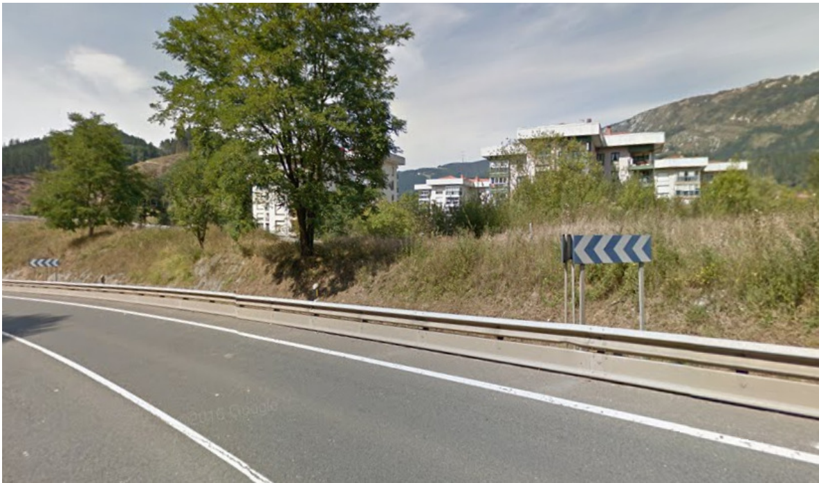
Detalle de las edificaciones próximas a la carretera en el municipio de Azkoitia
