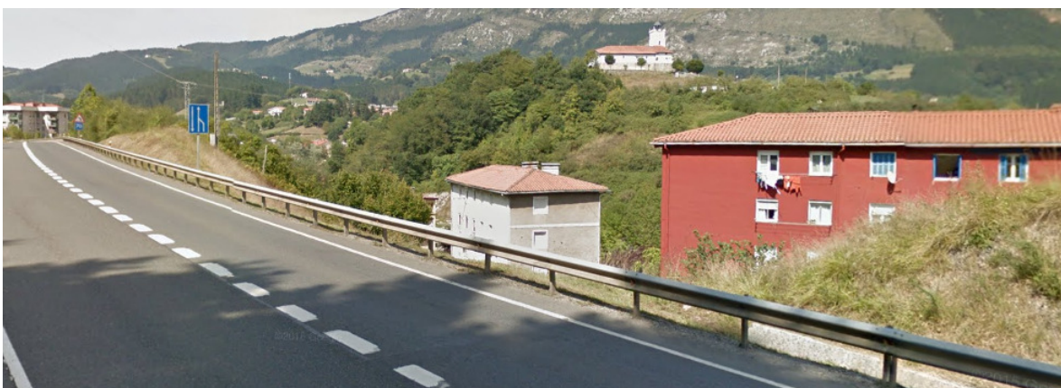
Detalle de las edificaciones próximas a la carretera en el municipio de Azkoitia
