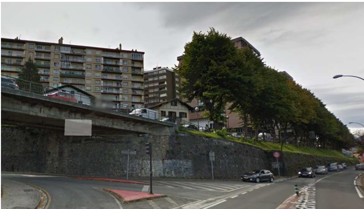
Sección de la vía frente a las edificaciones hacia el final de la UME
