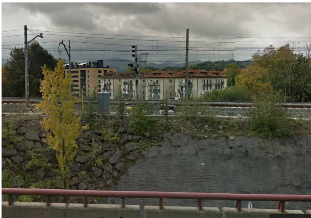
Final de la UME en Oiartzun, donde se identifica potencial afección en algunas zonas residenciales en medio de un entorno predominantemente industrial
