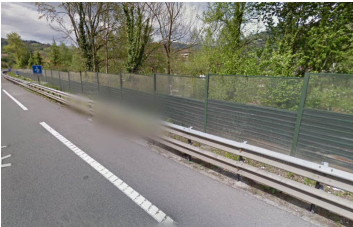
En el siguiente ámbito residencial, Barrio Bidebieta, la afección de la vía cuenta con la protección de una pantalla acústica
