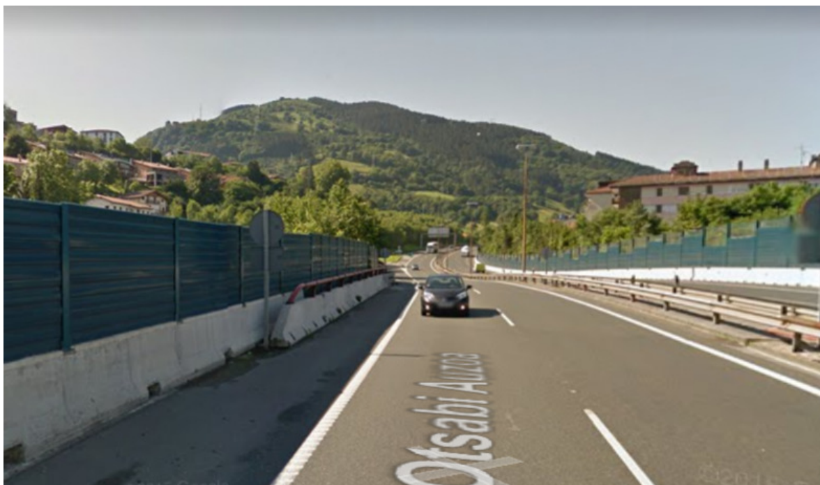
Bloques de altura variable a ambos lados de la vía a su paso por Villabona
