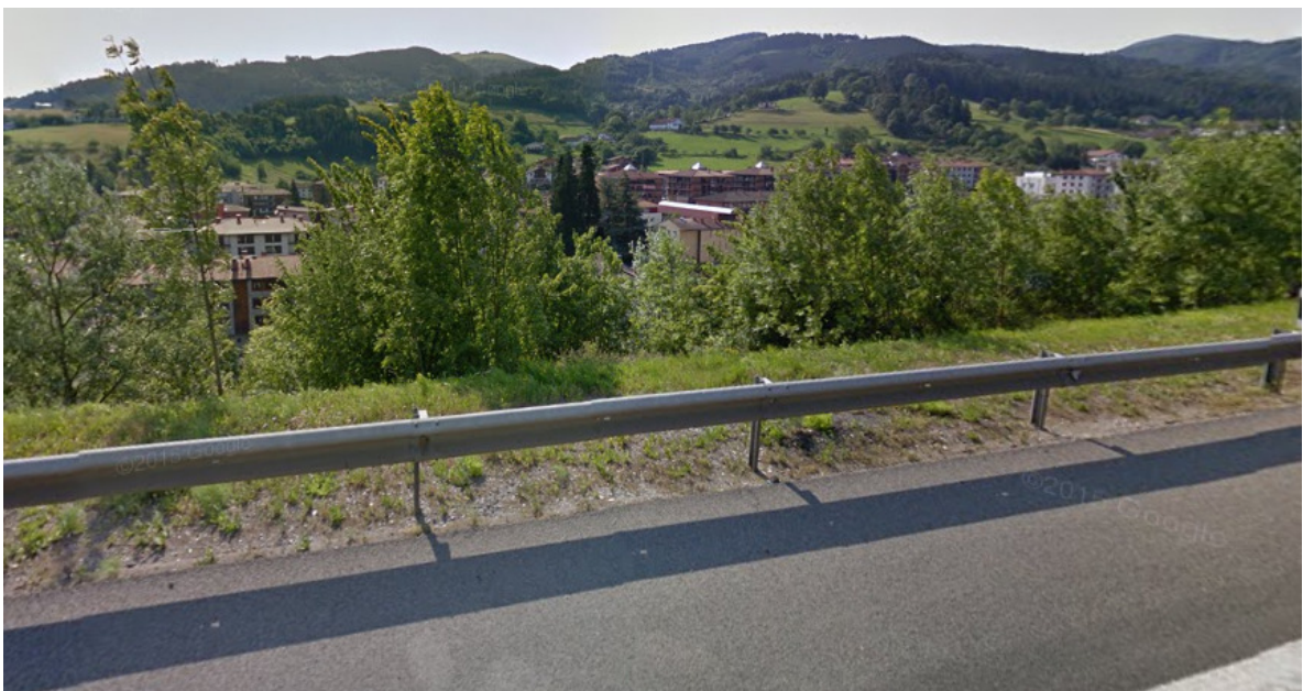
Paso de la UME por el casco urbano de Idiazabal, la sección de la vía está sobreelevada
