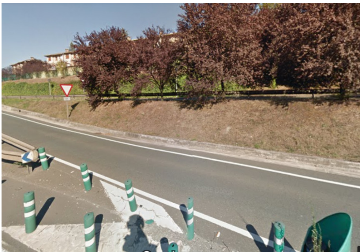
Imagen del ámbito de Ihurre en Olaberria con viviendas unifamiliares en primera línea frente a la infraestructura
