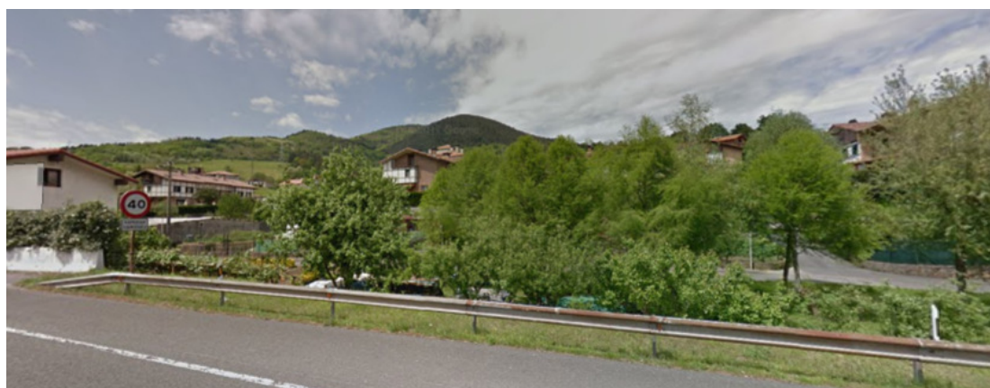
Margen norte en Andoain, caracterizado por viviendas unifamiliares a una distancia mínima de 60 metros
