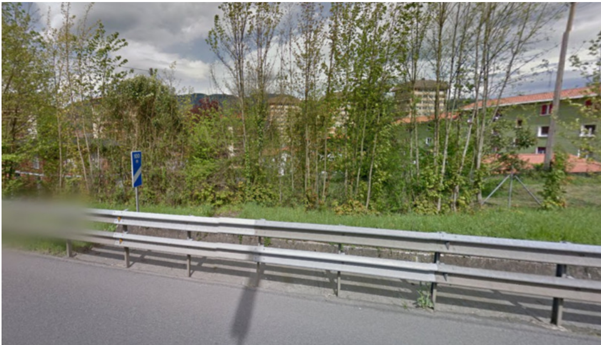
Primera zona residencial de Tolosa con visión directa a la vía caracterizada por bloques de viviendas de diferentes alturas
