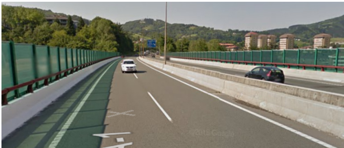
Pantallas acústicas sobre viaducto en Tolosa y sobre Ibarra
