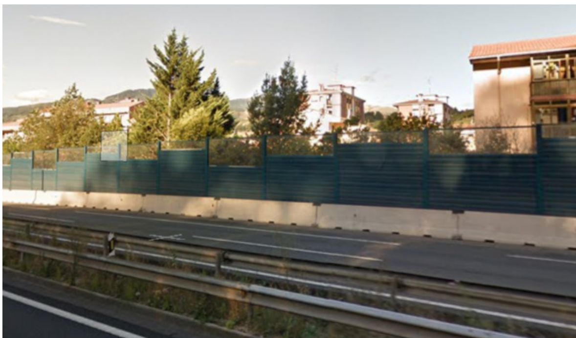
Paso de la N-I por Villabona con protección acústica para las edificaciones
