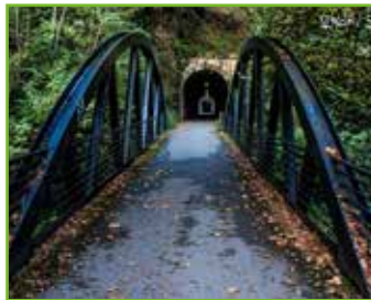
Avanzan las obras de ampliación del bidegorri de Zestoa
