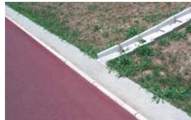
• Cuneta de hormigón y bajante de talud junto a una vía ciclista.
