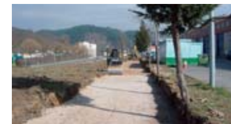
• Construcción de vía ciclista (Segura).
