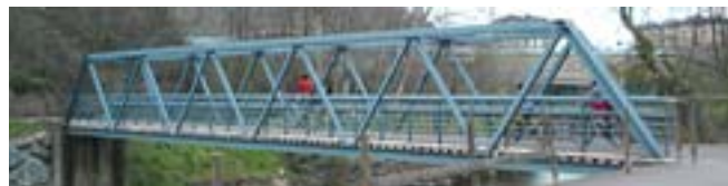
• Pasarela metálica peatonal y ciclista (Oiartzun).
