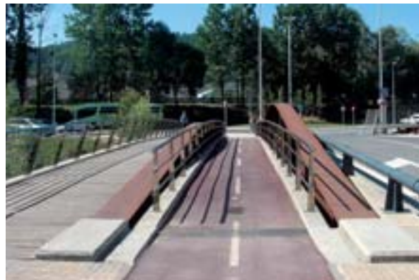
• Pasarela peatonal y ciclista (Tolosa).
