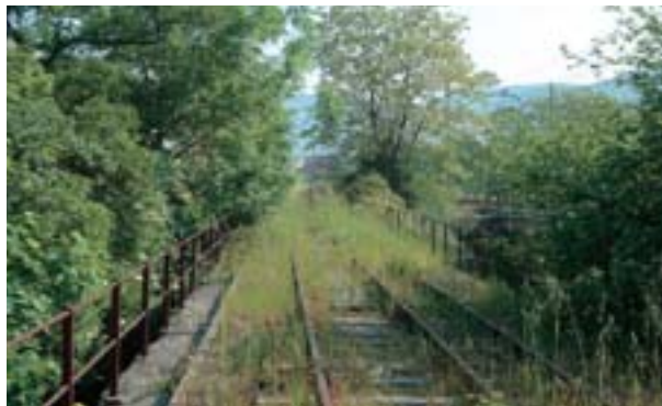
• Estado previo a la construcción de la senda bici (Legazpi).
