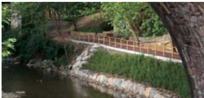
• Aspecto del emparrillado de madera tres meses después de su construcción (Errenteria).
