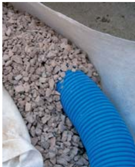
• Detalle de un dren.
