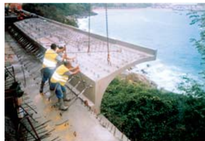
• Colocación de una de las piezas prefabricadas de un voladizo.
