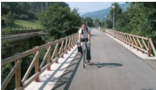
• Estado tras las obras de construcción (Legazpi).
