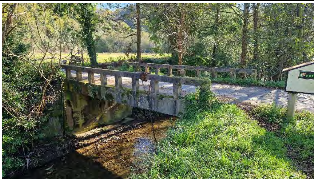
Fotografía nº 15 - Puente de paso junto a la zona de estudio
