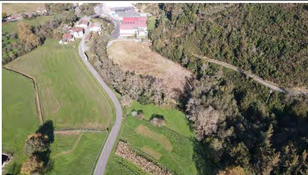
Fotografía nº 1 - Vista general del ámbito
