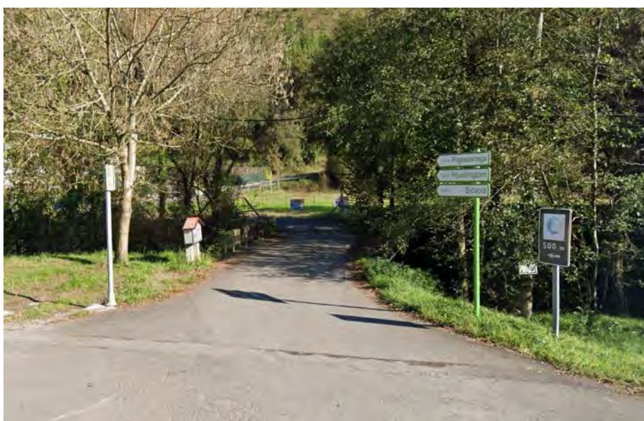
Fotografía 1 - Estructura 1. Vista desde su entrada desde la carretera foral GI-3710 (margen izquierda)
