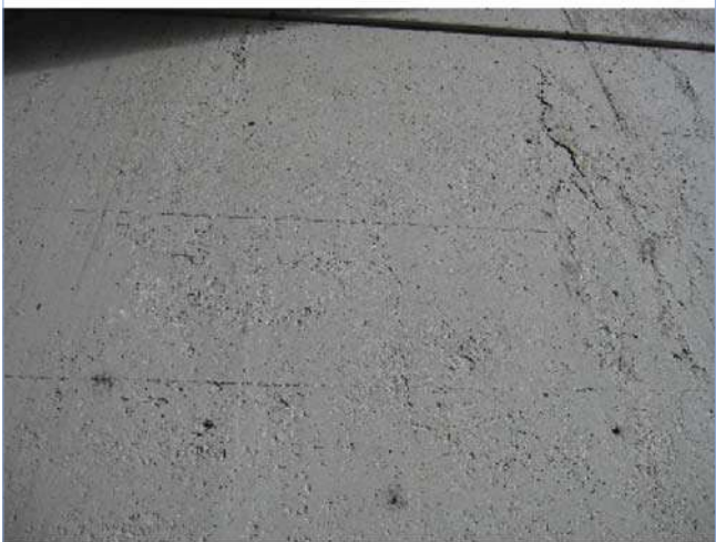
Fotografía 26: ZG4-446 IMG_5595 Fisura vertical E2
