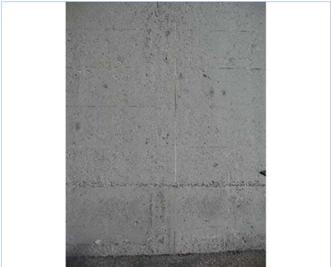
Fotografía 24: ZG4-446 IMG_5592 Fisura vertical E2
