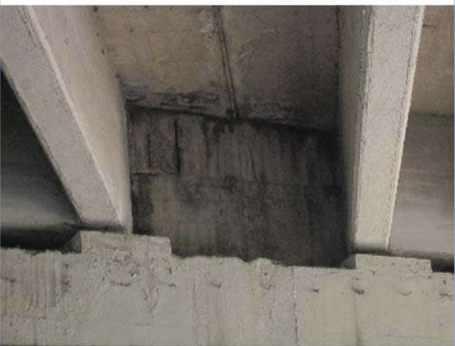
Fotografía 14: ZG4-446 IMG_5607 Armadura vista murete guarda E2
