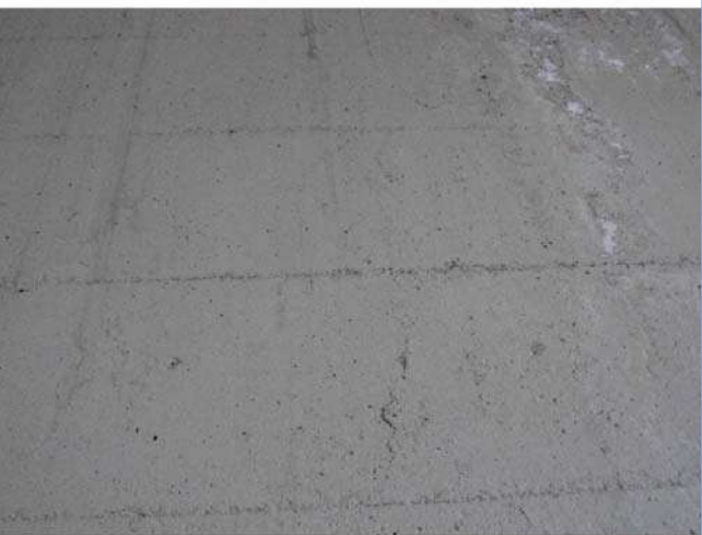
Fotografía 20: ZG4-446 IMG_5573 Fisura vertical E1
