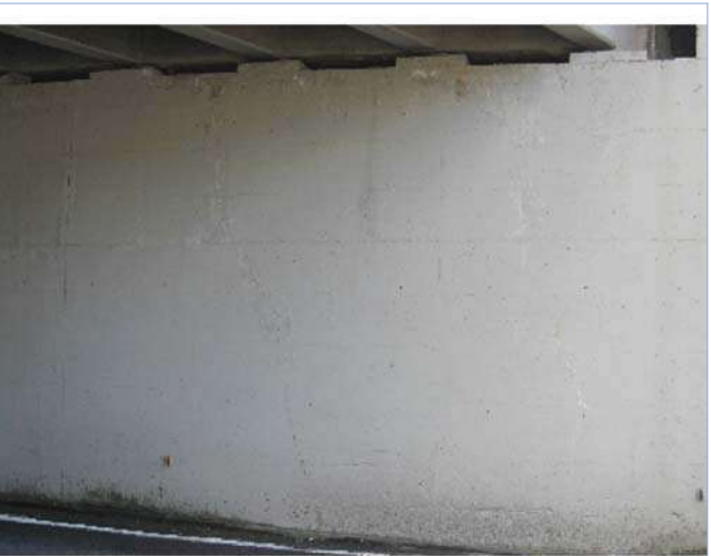
Fotografía 30: ZG4-446 IMG_5566 Fisura diagonal 4mm apertura en E1
