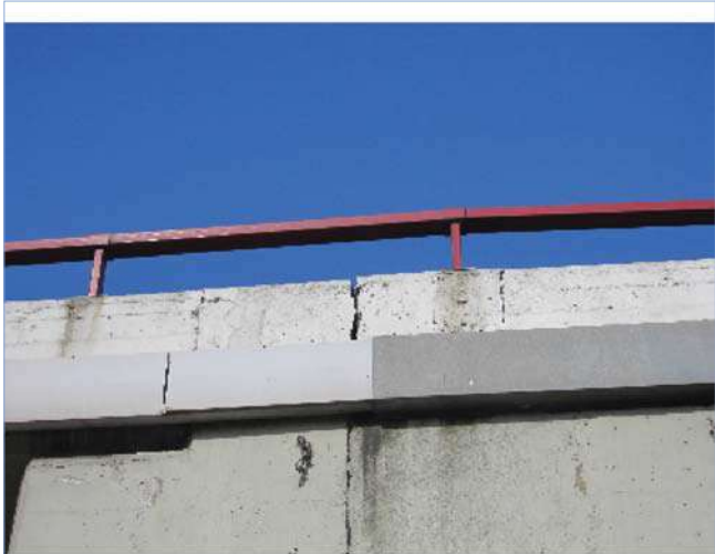
Fotografía 1: ZG4-446 IMG_5621 Rotura en junta pretil
