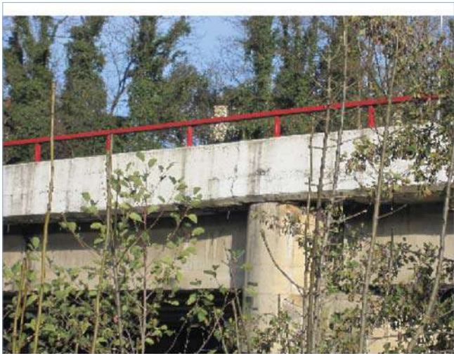
Fotografía 1: ZG4-447a IMG_7216 pretil - fisura vertical
