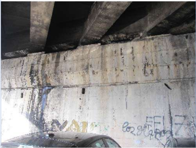
Fotografía 4: ZG4-447a IMG_7187 pila P01 - desconchones
