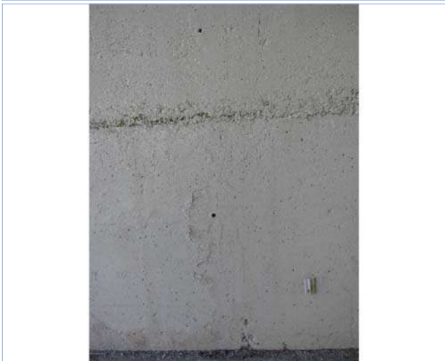
Fotografía 27: ZG4-446 IMG_5603 Fisura diagonal E2
