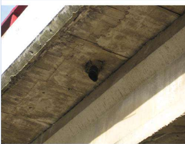
Fotografía 3: ZG4-447a IMG_7206 longitud imbornal insuficiente
