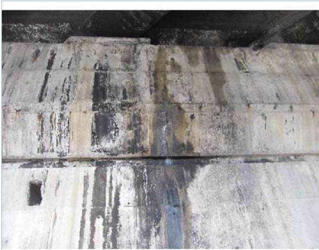
Fotografía 1: ZG4-447a IMG_7190 pila P01 - humedades
