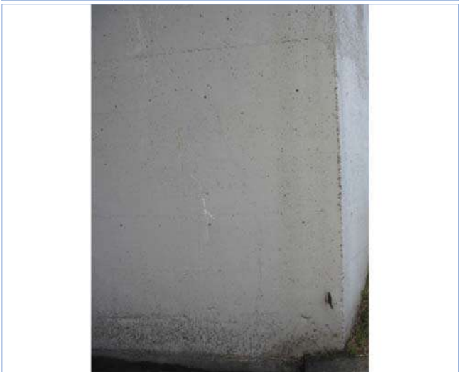
Fotografía 28: ZG4-446 IMG_5567 Fisura diagonal 4mm apertura en E1
