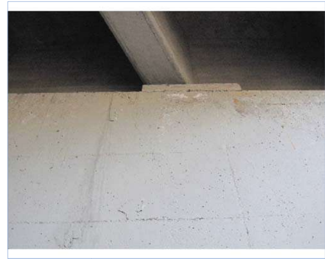
Fotografía 17: ZG4-446 IMG_5576 Fisura vertical E1
