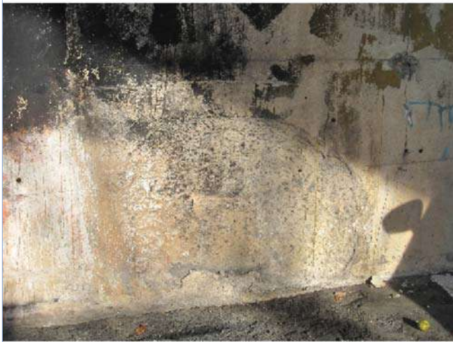
Fotografía 3: ZG4-447a IMG_7191 pila P01 - desconchones
