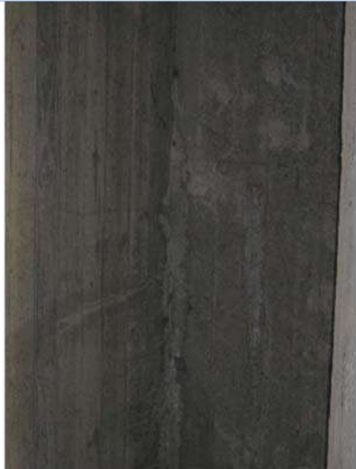
Fotografía 2: ZG4-446 IMG_5616 Fisuras transversales en vigas
