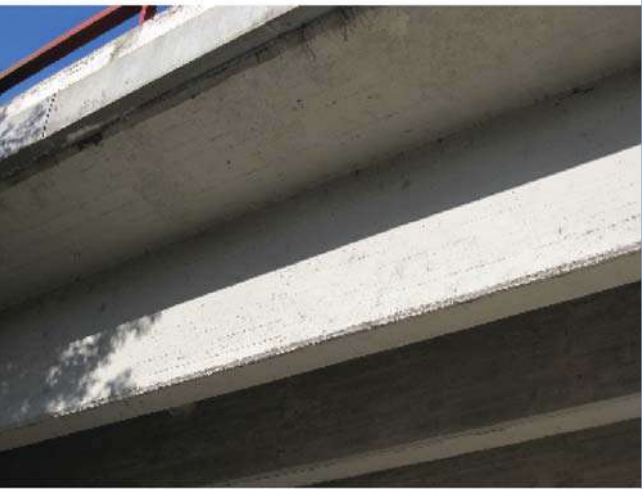
Fotografía 4: ZG4-446 IMG_5612 Fisuras transversales en vigas
