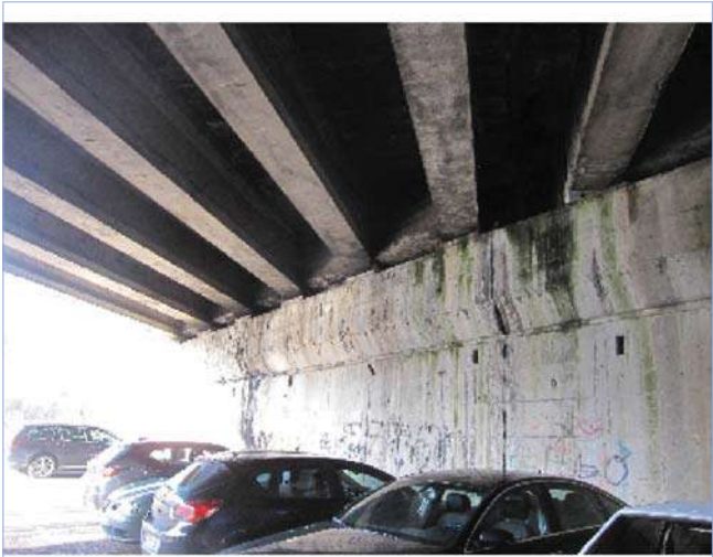
Fotografía 2: ZG4-447a IMG_7186 pila P01 - humedades
