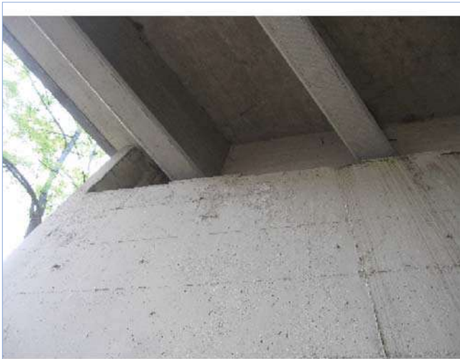
Fotografía 23: ZG4-446 IMG_5581 Fisura vertical E1
