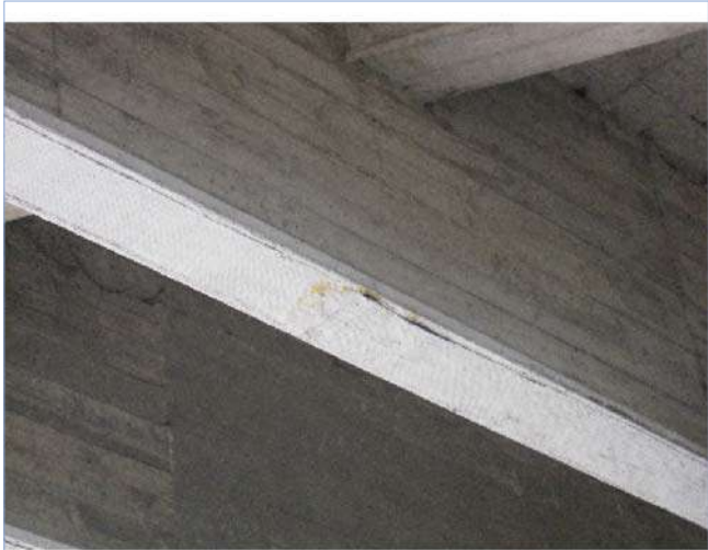
Fotografía 1: ZG4-446 IMG_5611 Puntos oxido ala inferior bajo refuerzo
