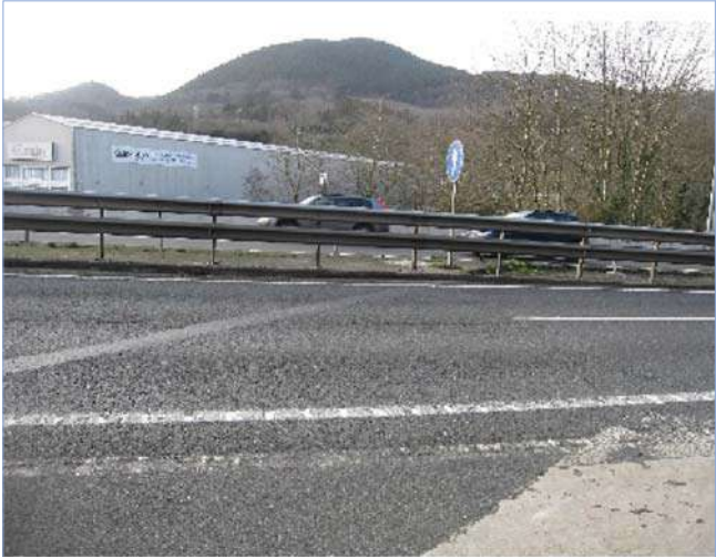
Fotografía 2: ZG4-447a IMG_7229 rotura pavimento calzada derecha
