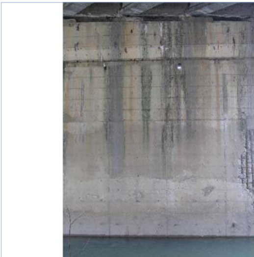
Fotografía 8: ZG4-447a IMG_7237 pila P04 - fisura vertical
