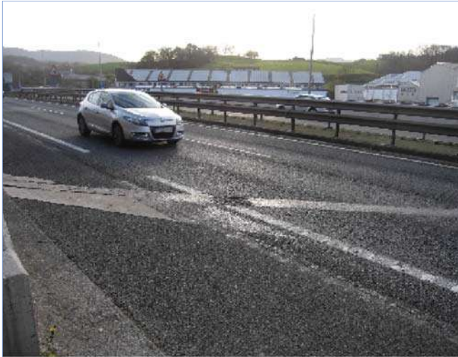
Fotografía 1: ZG4-447a IMG_7228 deformación pavimento sobre junta oculta calzada derecha
