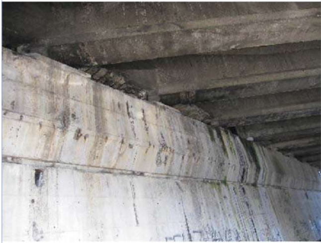
Fotografía 7: ZG4-447a IMG_7188 pila P01 - armaduras oxidadas
