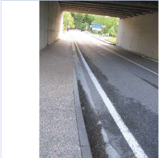
Fotografía 1: ZG4-446 IMG_5619 Cunetas obstruidas bajo obra
