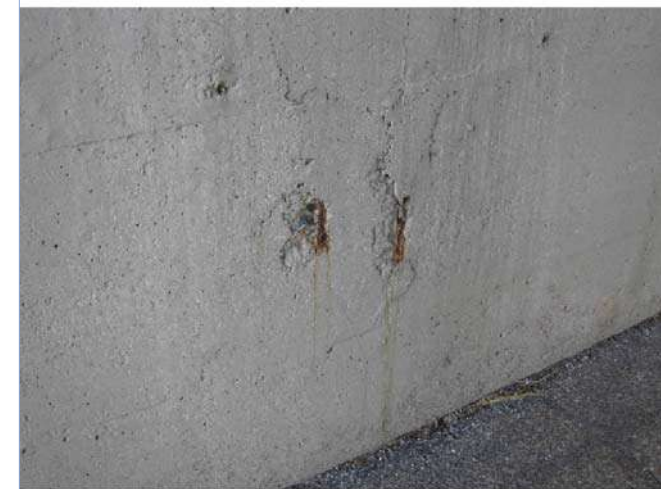
Fotografía 13: ZG4-446 IMG_5606 Armadura vista muro frontal E2
