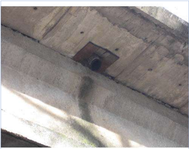
Fotografía 2: ZG4-447a IMG_7210 longitud imbornal insuficiente
