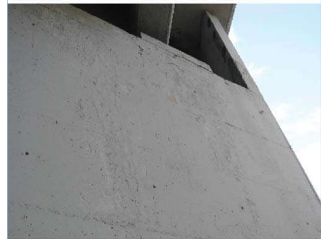
Fotografía 19: ZG4-446 IMG_5577 Fisura vertical E1
