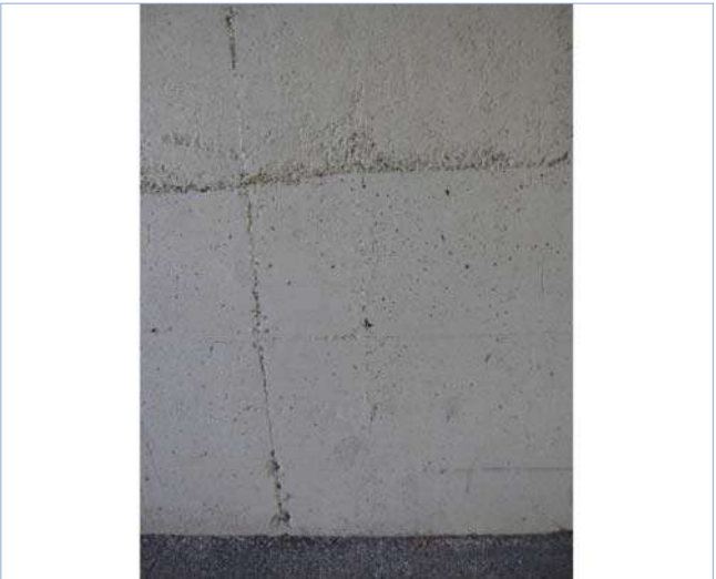
Fotografía 29: ZG4-446 IMG_5602 Fisura diagonal E2
