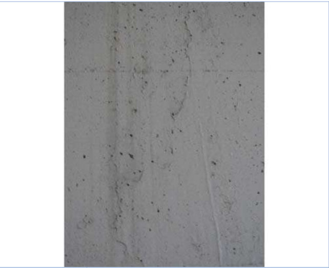
Fotografía 18: ZG4-446 IMG_5574 Fisura vertical E1
