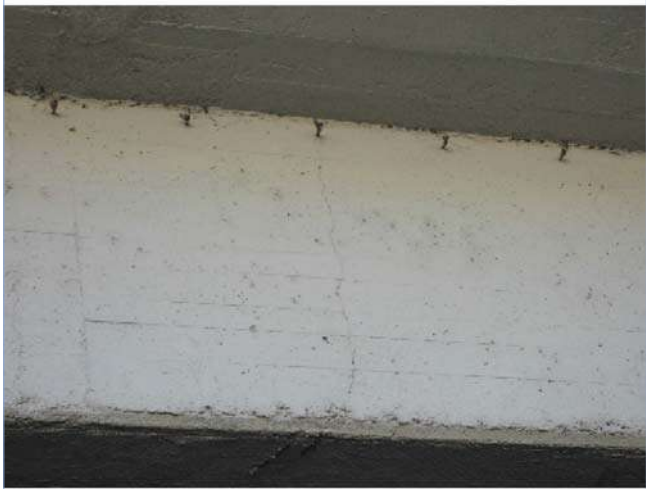
Fotografía 3: ZG4-446 IMG_5613 Fisuras transversales en vigas
