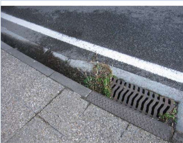
Fotografía 2: ZG4-446 IMG_5618 Cunetas obstruidas bajo obra
