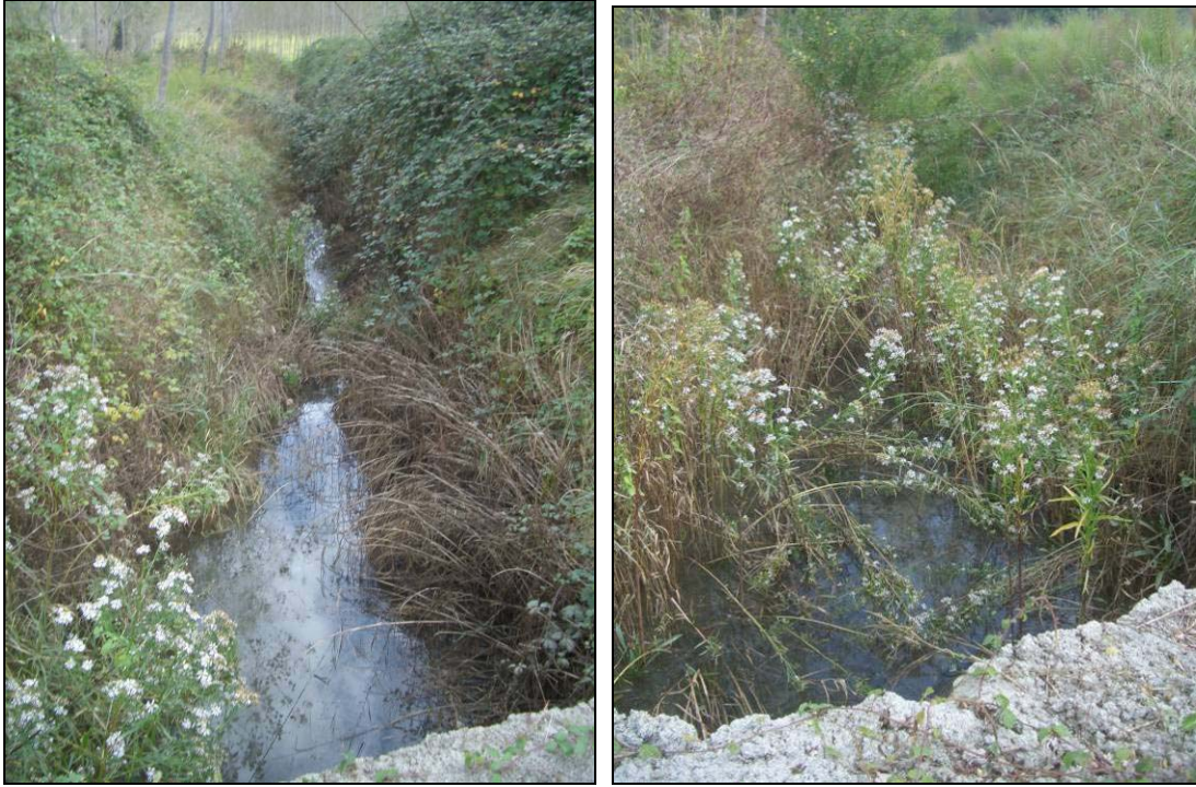
Fotos 1.3.8. y 1.3.9. Acequias de desagüe con salida a la ría por colectores, mediante arquetas de hormigón.
