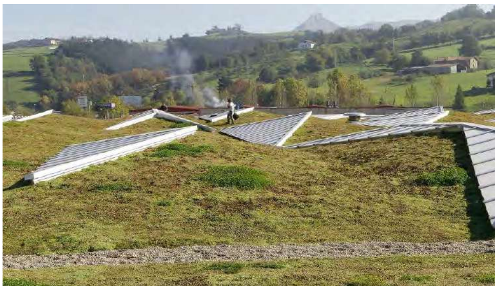
Imagen 003: Cubierta verde en una nave de mecanizado industrial de Ampo, Idiazabal, Guipúzcoa. Fuente: https://www.interempresas.net/Instaladores/Articulos/213156-Knauf-Insulation-instala-una-cubierta-verde-de-6800m2-en-Guipuzcoa.html
