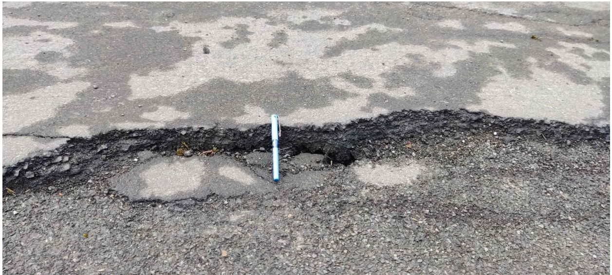
Figura 7. Fisuras a lo largo del tramo de estudio
