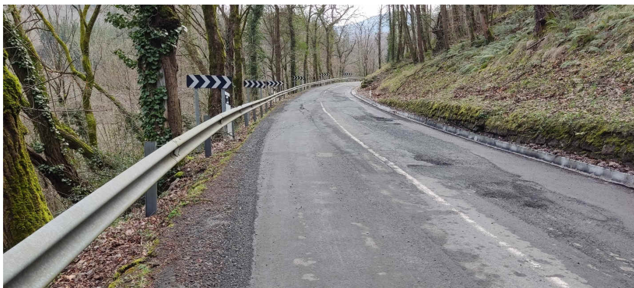
Figura 6. Aspecto deformado del vial.
