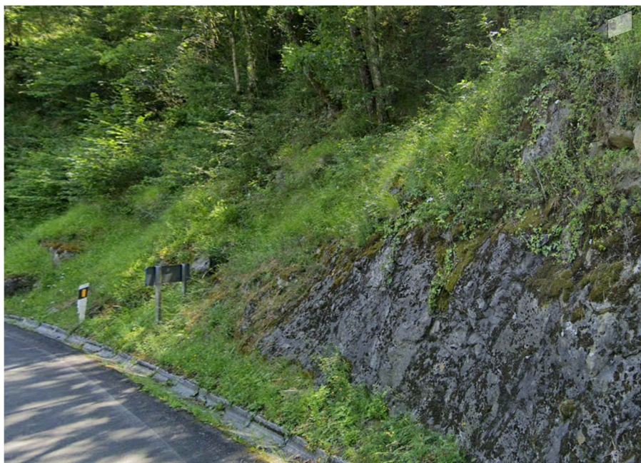
Figura 30. Sustrato rocoso ligeramente alterado en el talud del vial actual (fuera del ámbito de actuación)
