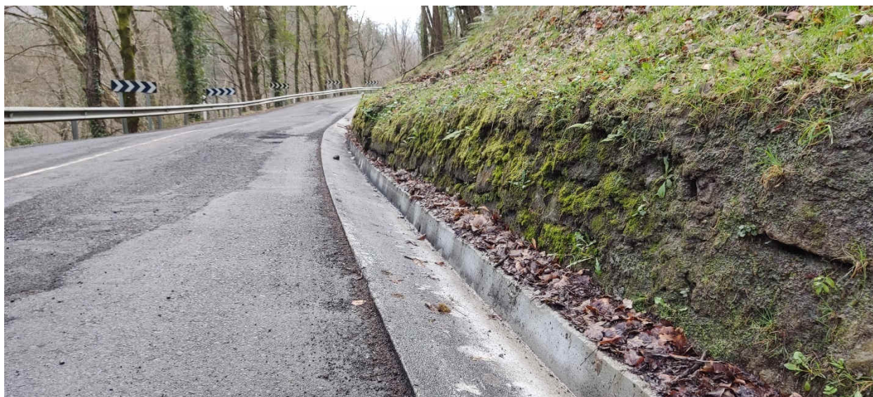
Figura 9. Muro de mampostería ubicado en el pie del desmonte.
