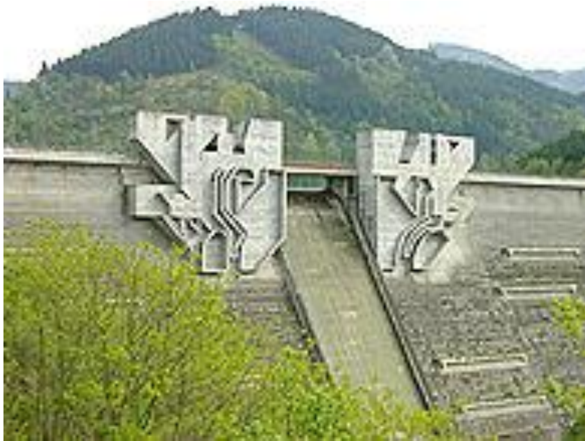
Presa del embalse de Arriaran / Arriaran urtegiko presa
