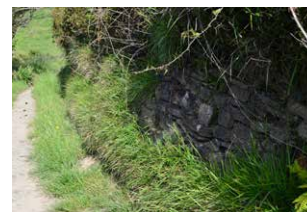
6. Muro de piedra al borde del camino
