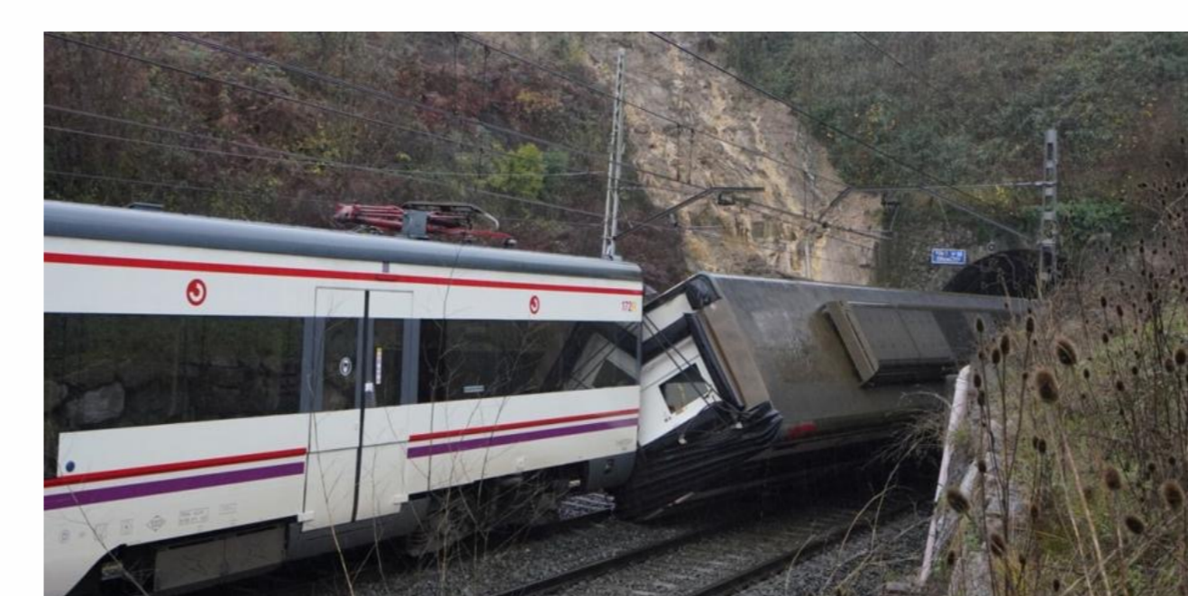
Deslizamiento y afección consiguiente de la línea de RENFE acontecida en la altura de Gabiria el 8/12/2021. Fuente: DV (2021)
